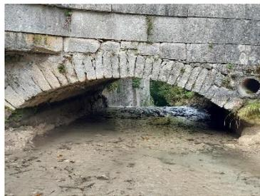
Le niveau actuel du fond du lit est le niveau initial lors de la construction de l'ouvrage, avec la réapparition d'une pierre taillée d'origine à l'aval du pont.
