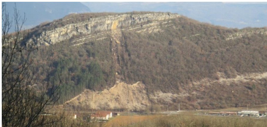
Chute de bloc rocheux - Rochers de la Craz
