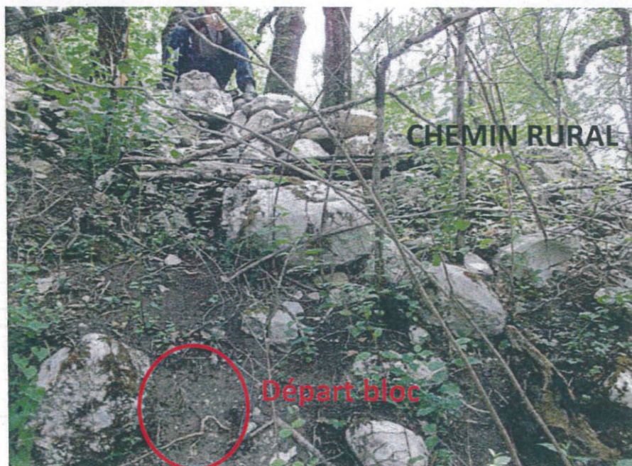
Zone de départ du bloc du 12 mai 2012
